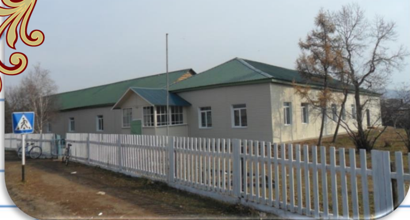
2010-2011гг. – капитальный ремонт основного здания.
