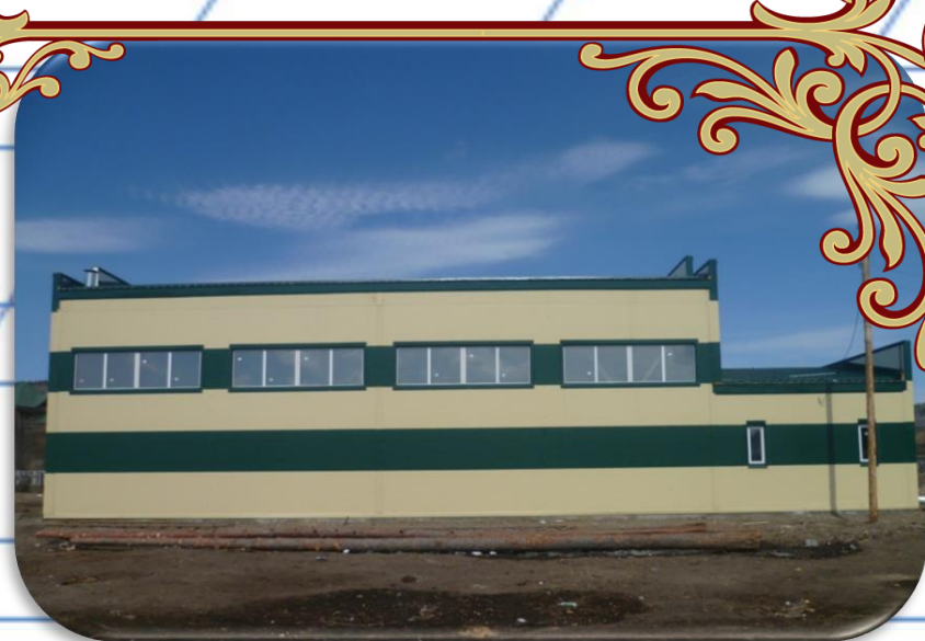
2012-13 г. – строительство спортивного зала
