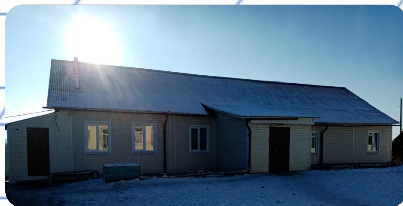
2019г. – капитальный ремонт здания начальной школы.
